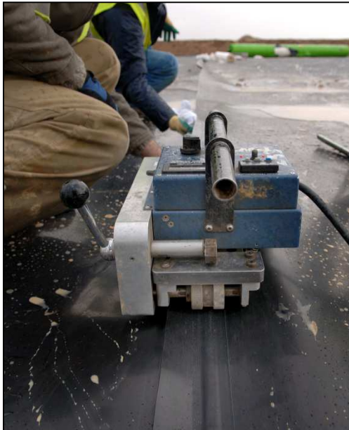
Exemple de mise en place de géomembrane
